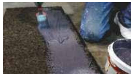
10. Applicazione della colla bituminosa sul pannello
