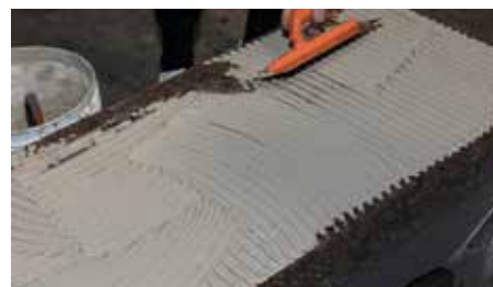
2. Stesura del collante sul pannello CORKPAN MD FACCIATA
