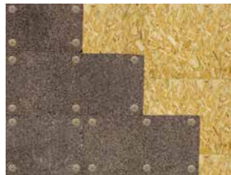
13. Dettaglio della posizione dei tasselli su legno
