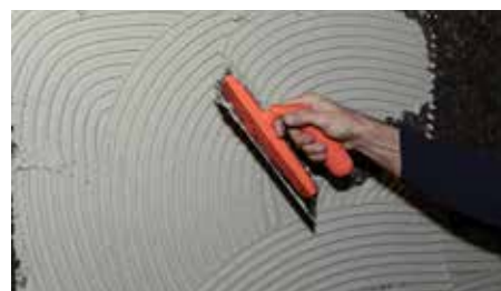
1. Stesura collante ISOVIT E-CORK MD sul supporto
