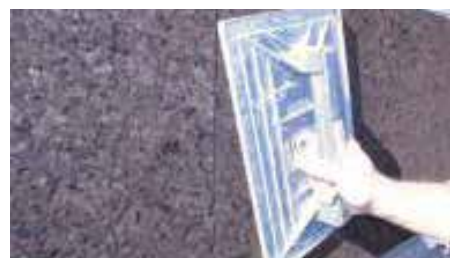
4. Verificare e correggere la planarità del rivestimento
