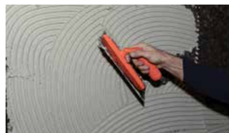
1. Stesura collante TECNOFIX MD sul supporto
