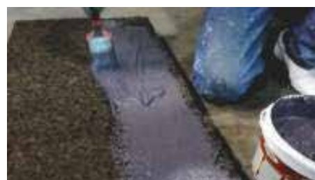
10. Applicazione della colla bituminosa sul pannello
