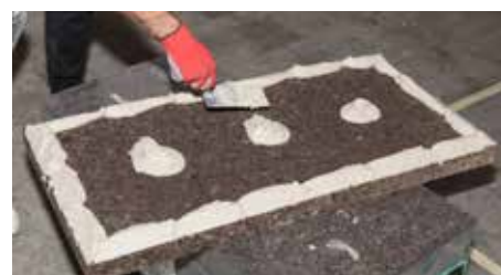
6. Applicazione del collante TECNOCORK P10 sul pannello
