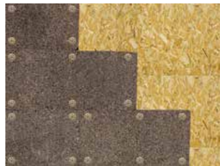
13. Dettaglio della posizione dei tasselli su legno
