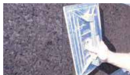
4. Verificare e correggere la planarità del rivestimento
