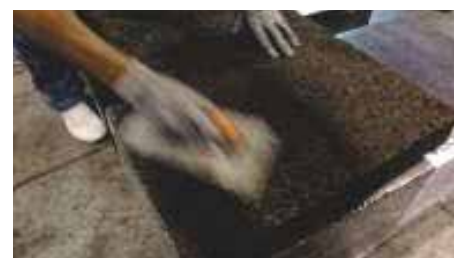
9. Creazione dello scasso per ospitare il collante bituminoso e lo spessore della guaina
