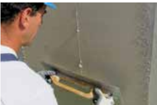
Applicazione della prima mano di REABILITA CAL
