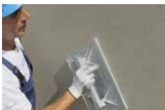
Spatolatura a taloscia della seconda mano
