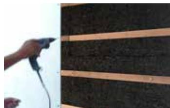
Seguire le indicazioni del progettista per predisporre gli alloggiamenti per i diversi impianti. In corrispondenza delle scatolette elettriche, si consiglia di posizionare uno strato di materiale isolante tra il muro e la cassetta elettrica.
