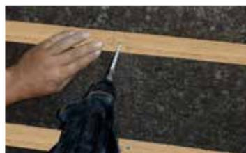
Praticare un prefuro nel pannello e nel muro svasando il foro di entrata nel legno, per ospitare la testa della vite. In alternativa utilizzare una punta con svasatore.
