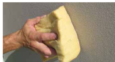
15. Spugnatura della superficie per ottenere un intonaco fine
