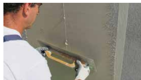
13. Applicazione della prima mano di REABILITA CAL AC
