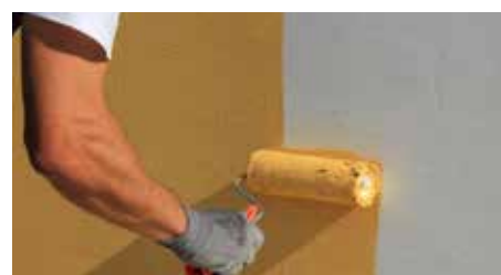
17. Applicazione della tinta ISOVIT REV SP
