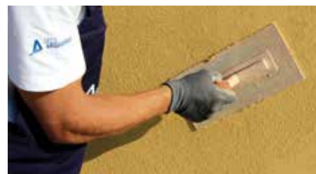
18. Applicazione della finitura a spessore
