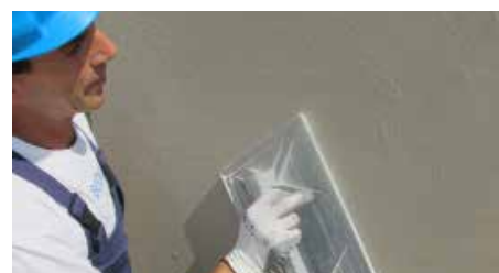
14. Spatolatura a taloscia della seconda mano di finitura REABILITA CAL AC
