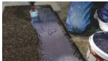
2. Applicazione della colla bituminosa sul pannello
