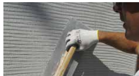
11. Annegamento della rete di rinforzo
