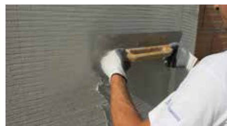
12. Seconda stesura di ISOVIT E-CORK
