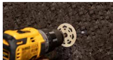
5. Avvitare le viti in acciaio all'interno della rosetta
