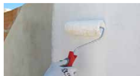
16. Applicazione del fondo ISOVIT AD 25 neutro o AD 20 SLS pre-colorato
