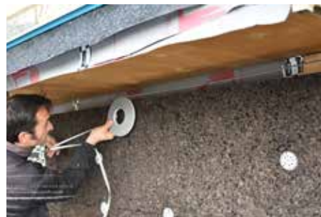
9. Applicazione del nastro espandente TECNOTAPE BG1
