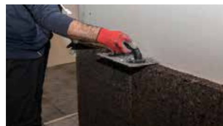
4. Dopo la posa di ogni pannello, verificare l'allineamento e la planarità delle superfici.
