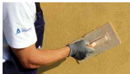
19. Applicazione della finitura ISOVIT REV SLS
