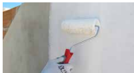
17. Applicazione di ISOVIT REV SP sopra ISOVIT AD 25
