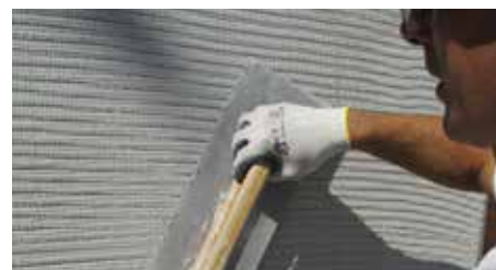
12. Inserimento della rete di rinforzo TECNORETE 150
