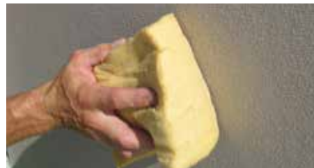
16. Spugnatura della superficie per ottenere un intonaco fine
