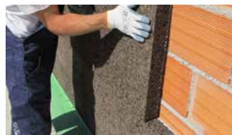
5. Il pannello deve essere fissato esercitando una pressione contro il supporto.
