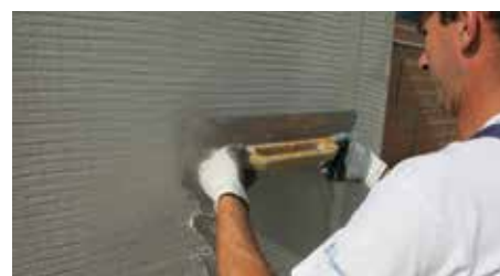
13. Seconda stesura di ISOVIT E-CORK
