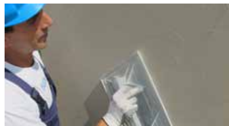
15. Spatolatura a taloscia della seconda mano di finitura REABILITA CAL AC
