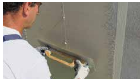
14. Applicazione della prima mano di REABILITA CAL AC
