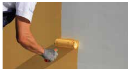
18. Applicazione del primer ISOVIT AD 20 SLS
