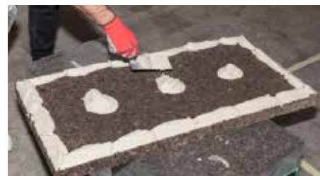
2. Stesura del collante ISOVIT E-CORK sul pannello, con modalità a cordoli e punti.
