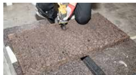
1. Taglio dei pannelli con strumenti di taglio idonei allo spessore
