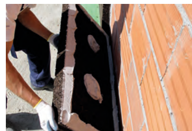
1. Stesura del collante ADHERE Vit ecoCORK sul pannello, con modalità a seconda del tipo di supporto.
