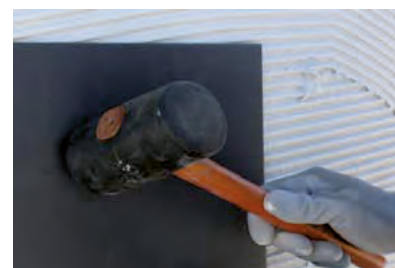
18. Fissaggio dell'elemento di ricestimento.
