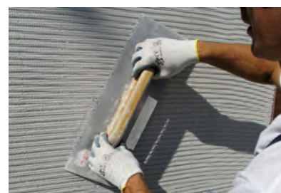
5. Annegamento della rete di rinforzo TecnoRete 150
