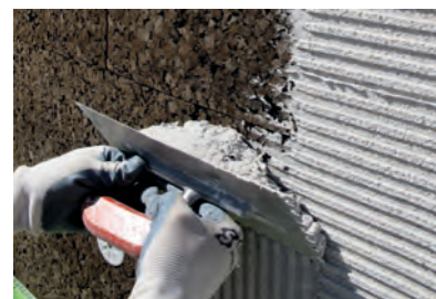
4. Applicare il primo strato di armato
