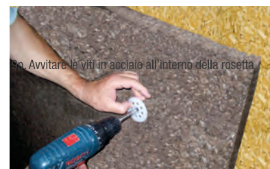
11. Avvitare le viti in acciaio all'interno della rosetta
