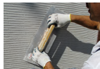
13. Annegamento della rete di rinforzo
