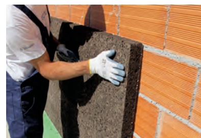
2. Il pannello deve essere fissato esercitando una pressione contro il supporto.
