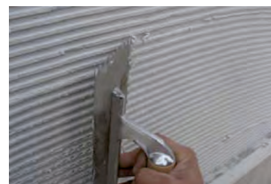
17. Stesura del collante ADHERE Multiflex.
