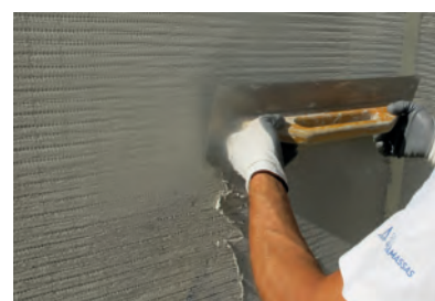
14. Seconda stesura di ADHERE Vit ecoCORK
