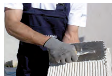
20. Doppia stesura di ADHERE Multiplex per elementi di grandi dimensioni.
