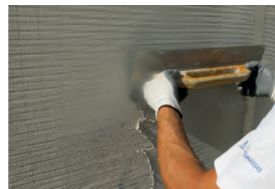
6. Seconda mano del primo strato armato
