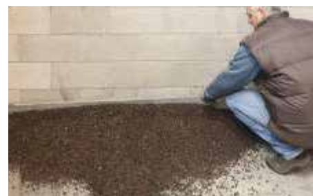
Stendere l'impasto e livellarlo con l'uso di una staggia.
