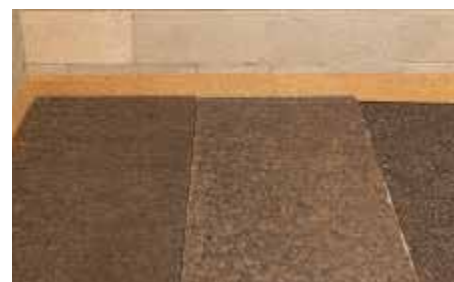
In caso di spessori elevati, posare CORKPAN
