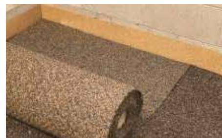
Disporre lo strato di isolamento acustico U32, U38 e U85 o COCCO PAV a tutta superficie.
