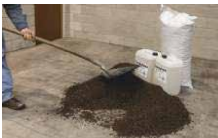
Miscelare 1 m 3 di CORKGRAN TOSTATO con 70 kg di vetrificante CORKGLASS .
