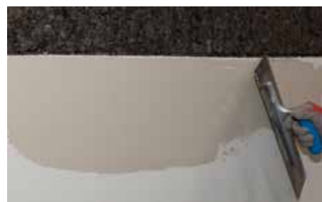
8. Applicazione del primo strato di CALCINA
