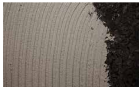
6. Applicazione primo strato di rasante ISOVIT E-CORK
