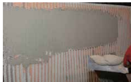
7. Applicazione del secondo strato di ISOVIT E-CORK
